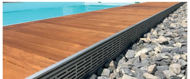
Beim Anschluss zwischen Terrassendielen und Rasenfläche sollte berücksichtigt werden, dass keine Feuchtigkeit aus der Rasenfläche in die Unterkonstruktion einwandert und eine Beschädigung der gesamten Konstruktion durch Rasenmähen erfolgt.
