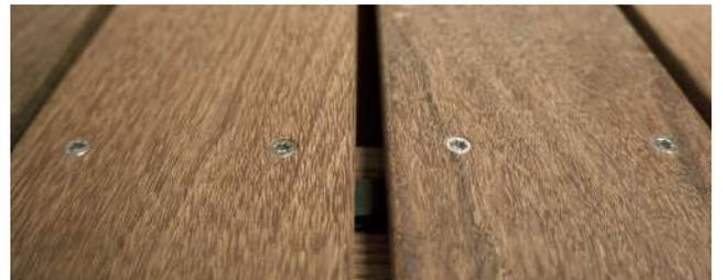
Die ideale Schraubenlänge hat die 2 ½ - bzw. 3fache Länge der Dielenstärke. Der ideale Abstand der Schrauben zur Stirnseite liegt bei 50 bis max. 100mm. Der längsseitige Randabstand jeder Schraube sollte mind. 15mm betragen.
